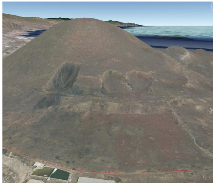
Ilustración 12: Huellas de importantes extracciones de áridos en la ladera oeste de Montaña Grande, dentro de los límites de la ZEC.
