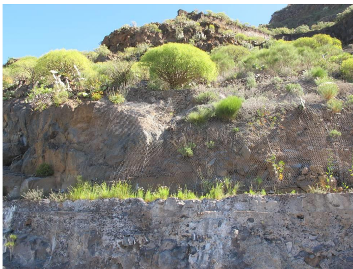
Figura 7: Mallas de protección frente a desprendimientos en la ZEC Riscos de Lara.
