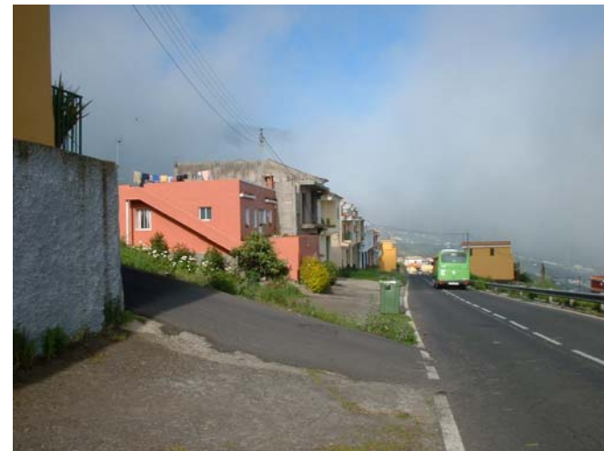
Edificaciones residenciales ubicadas dentro del ámbito de estudio Benijos - T.M. de La Orotava
