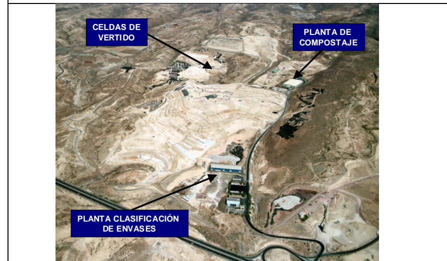
Figura 2. Estructura del Complejo Ambiental de Tenerife
