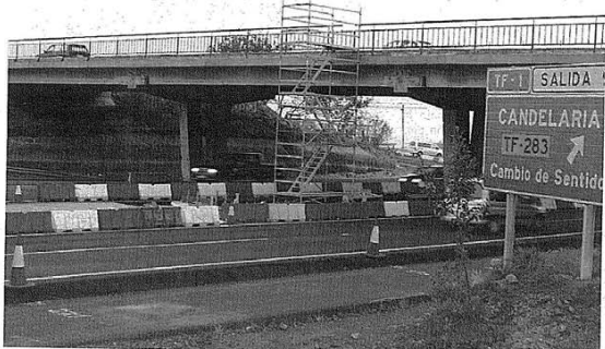
Trabajos en la autopista del sur, a la altura de Candelaria, con motivo de la ampliación del tercer carril. / DA
