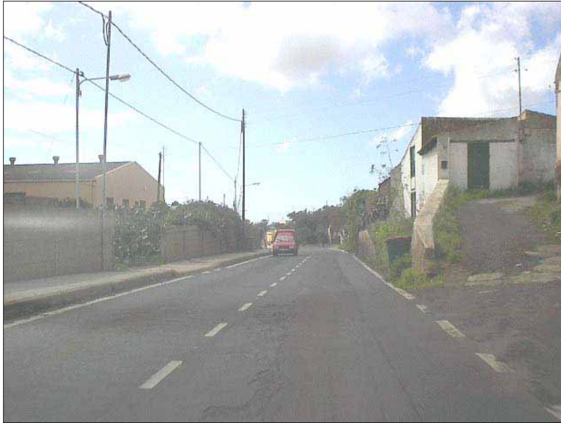
Carretera de San Miguel de Geneto (TF-263).
