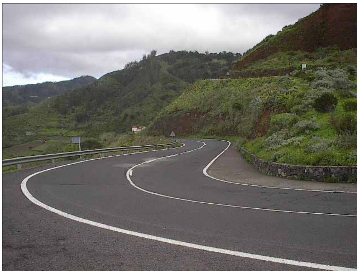
Carretera de El Boquerón (TF-156).
