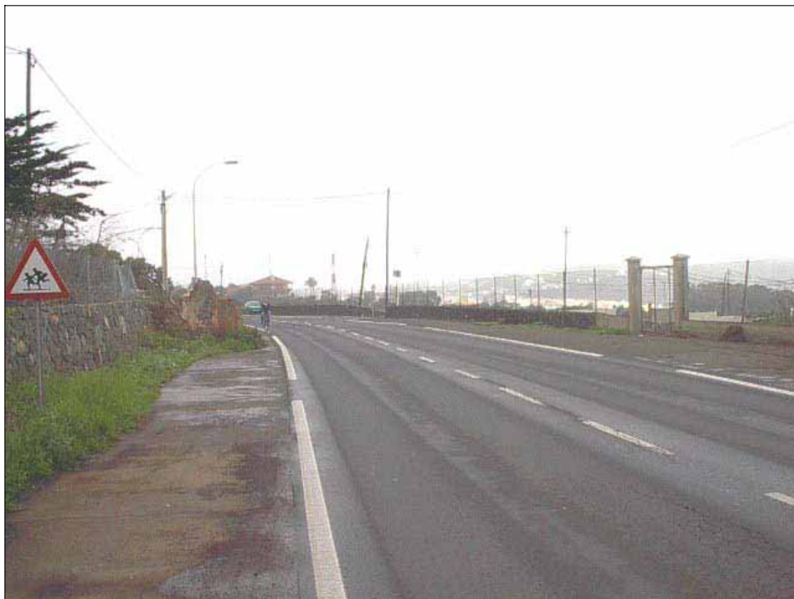
Carretera La Laguna – Llano del Moro (TF-265).
