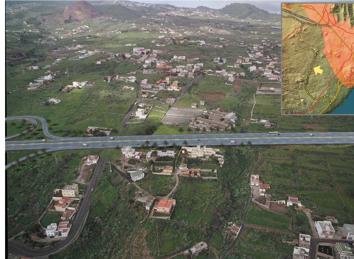
Continuación de la Circunvalación Oeste a su llegada al Enlace de El Sobradillo.
