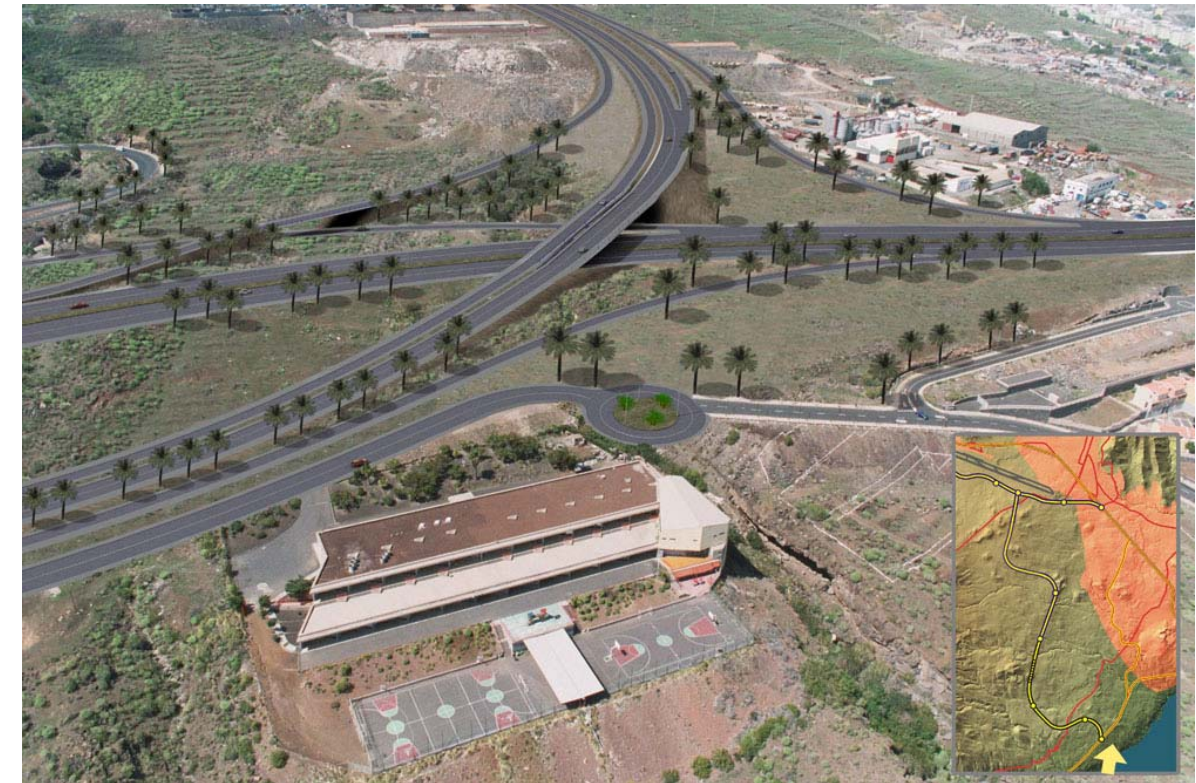
Vista de parte de la conexión entre la Circunvalación Oeste y la TF-1.
