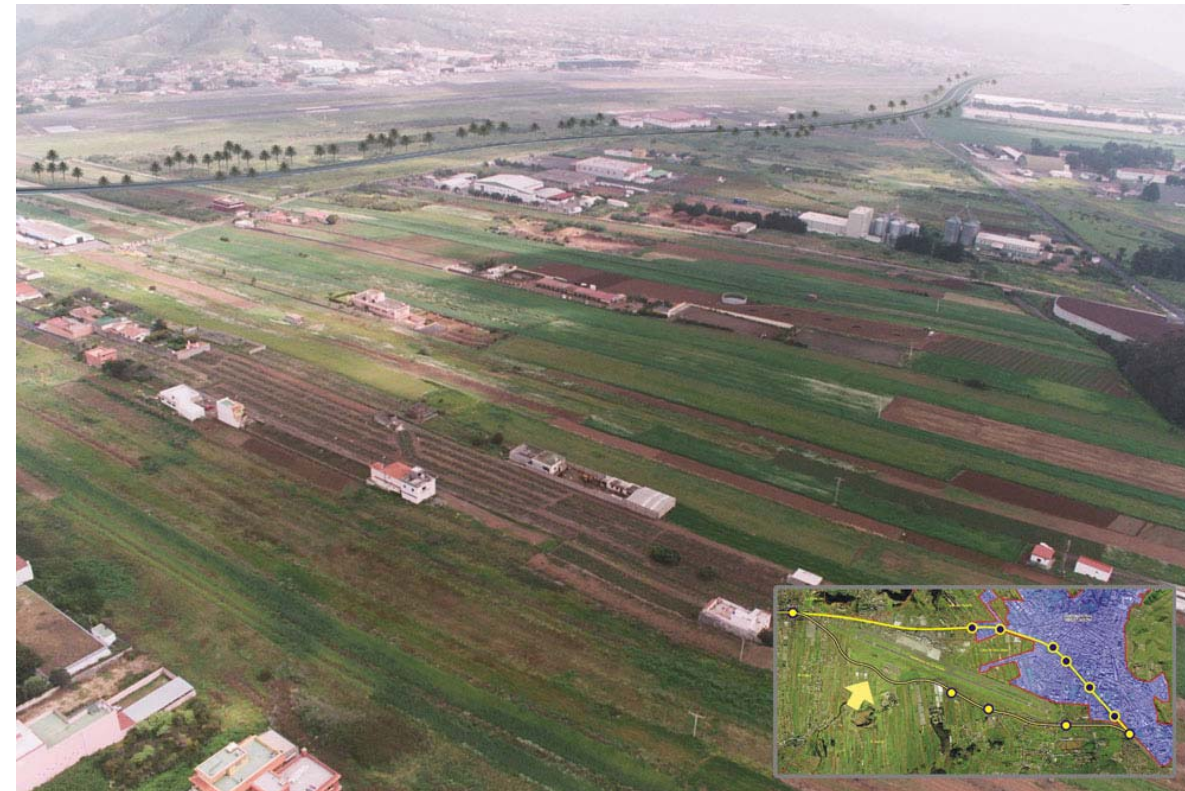
Tramo de la Circunvalación Oeste paralelo a la pista del aeropuerto.
