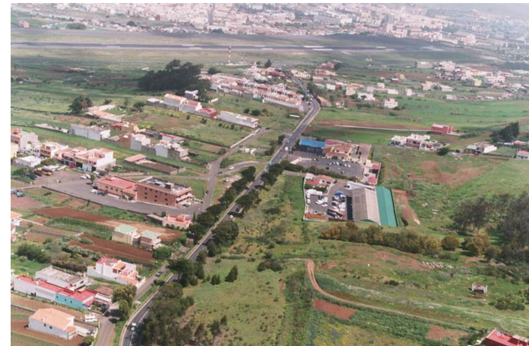
La Circunvalación Oeste va a representar una reorganización de las comunicaciones de la zona sur de la ciudad de La Laguna
