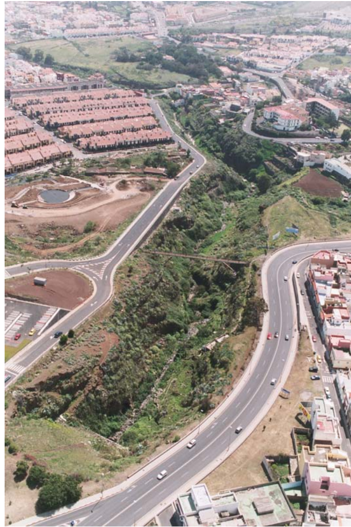
Barranco de Gonzalíñez. En medio de la zona urbana, su espacio permitirá la ejecución del enlace de conexión de la Circunvalación Norte con la TF-13.
