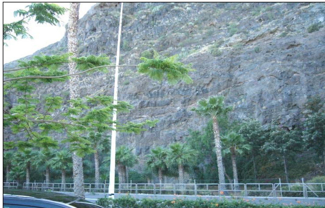
Foto 1- Extremo este de la Vía de Cornisa. En la imagen tenemos el punto exacto de salida de la vía, que será en la zona de jardinería de la fotografía.
