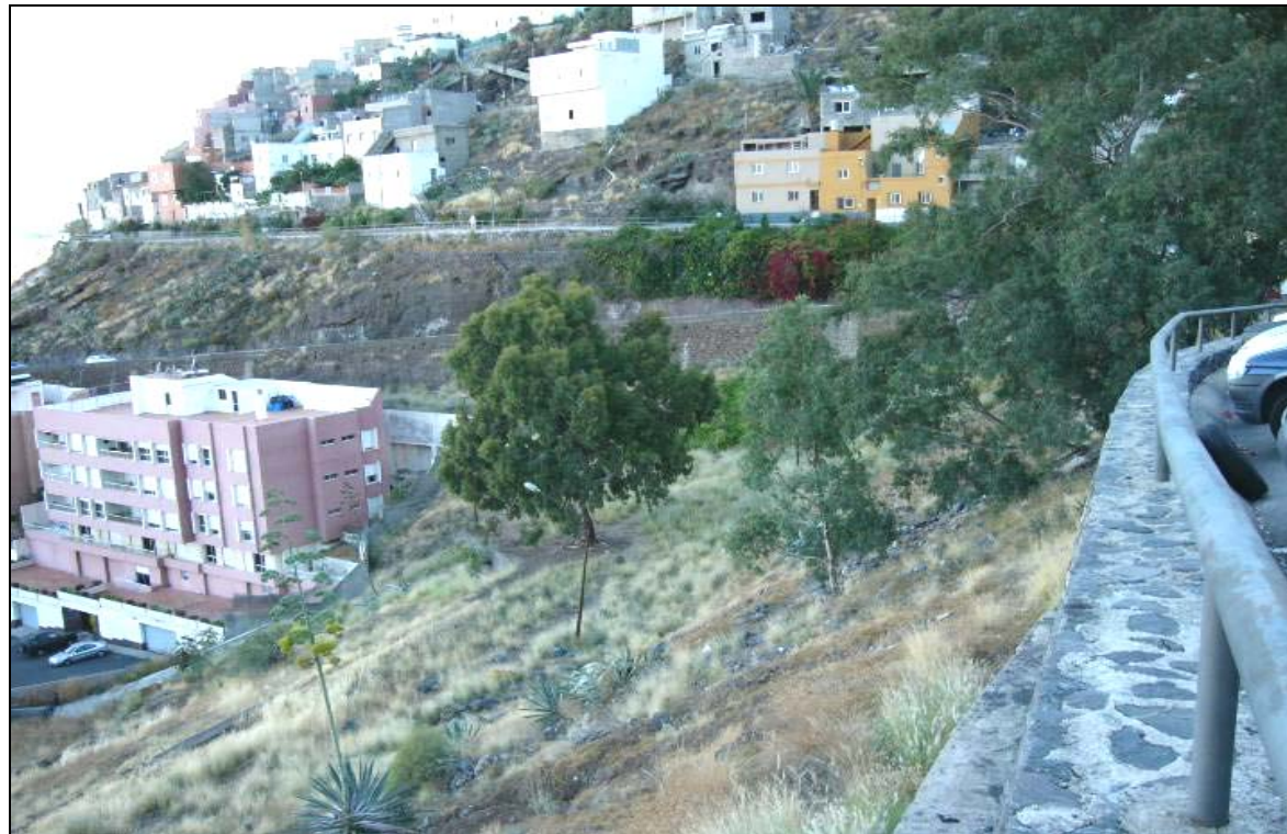
Localidad de Las Acacias, en donde la vía “aflora” a la superficie tras un recorrido subterráneo relativamente largo.
