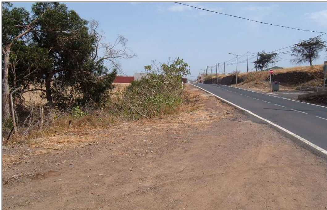
Foto 18- Lugar por donde pasa la vía en intersección con la TF-111. Los arcenes de esta vía se encuentran desprovistos de vegetación, excepto por algunos pies arbóreos de Eucaliptus globulus .
