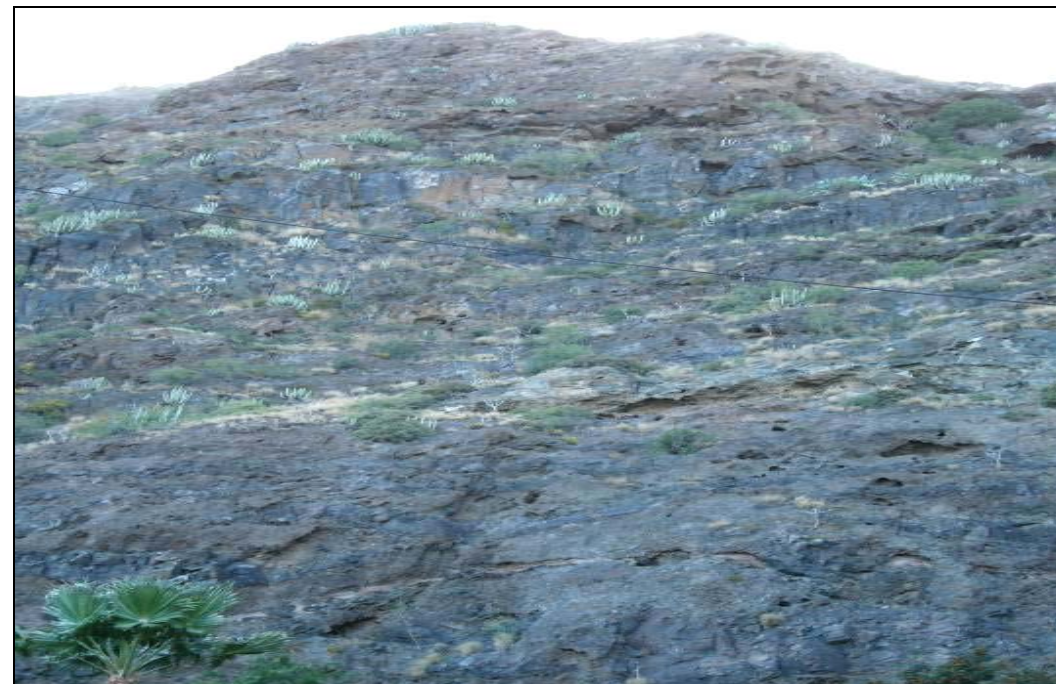
Foto 3- Las obras del túnel no afectarán a los reductos de vegetación basal presentes, cercanos a la zona de jardinería del extremo oeste de la vía.
