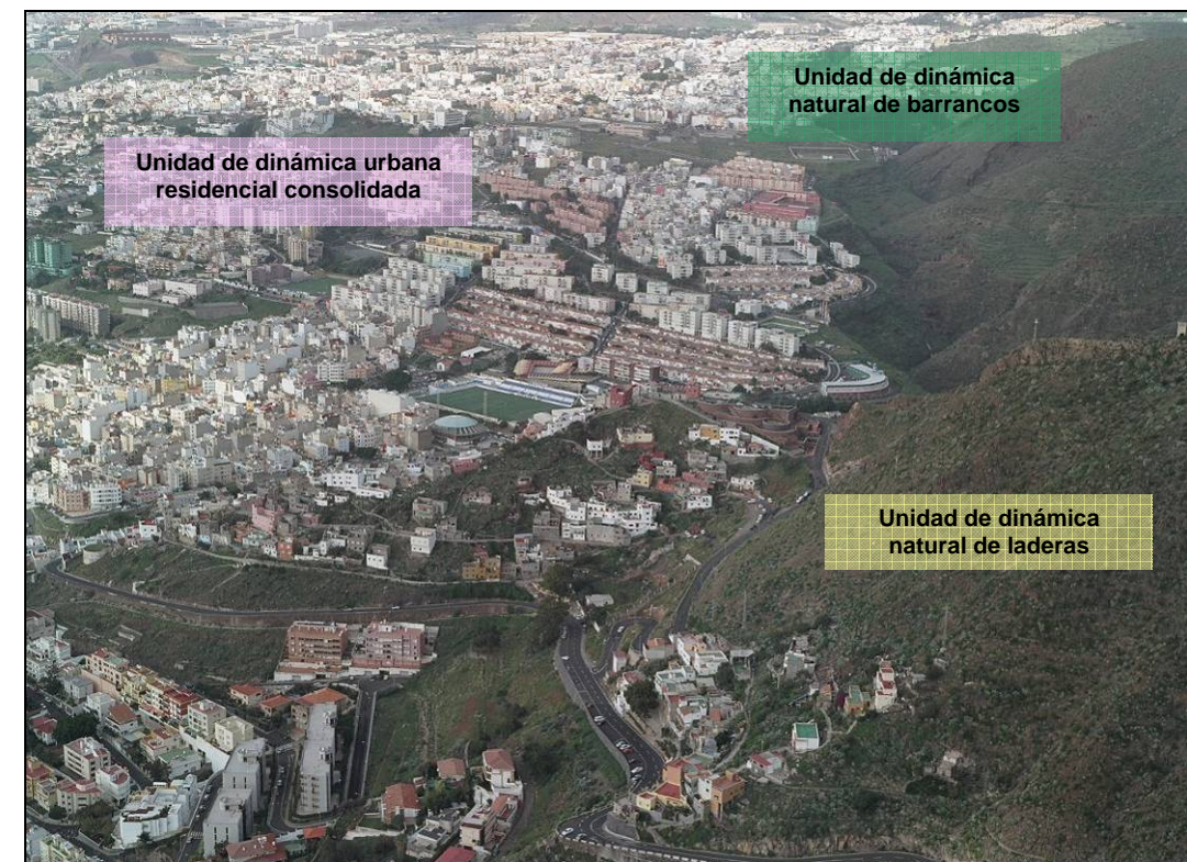
Principales unidades ambientales homogéneas por las que se desarrolla la Circunvalación Norte.
