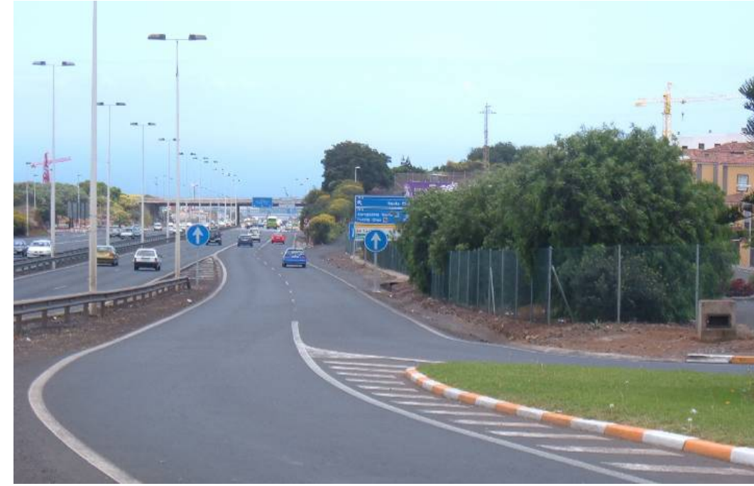
Foto 27- Visión hacia el Sureste de una vía de conexión con la TF-5. Existe vegetación de Schinus molle (Falso pimentero) de cierto desarrollo.
