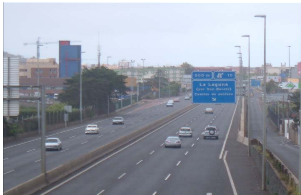
Foto 38- El sector medio-oeste de la actual vía apenas posee vegetación. En sus márgenes susceptibles de ser afectados por la propuesta, se observa que en el margen derecho no existe apenas poblamiento natural.
