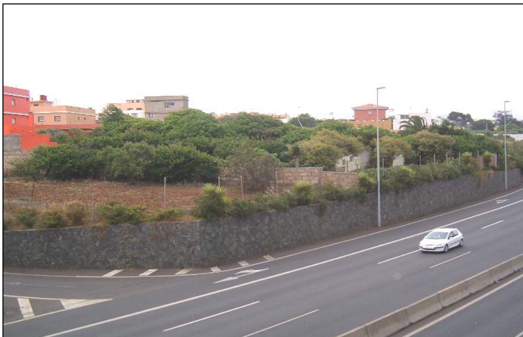
Foto 42- Detalle ampliado del margen oeste de la traza de la vía.
