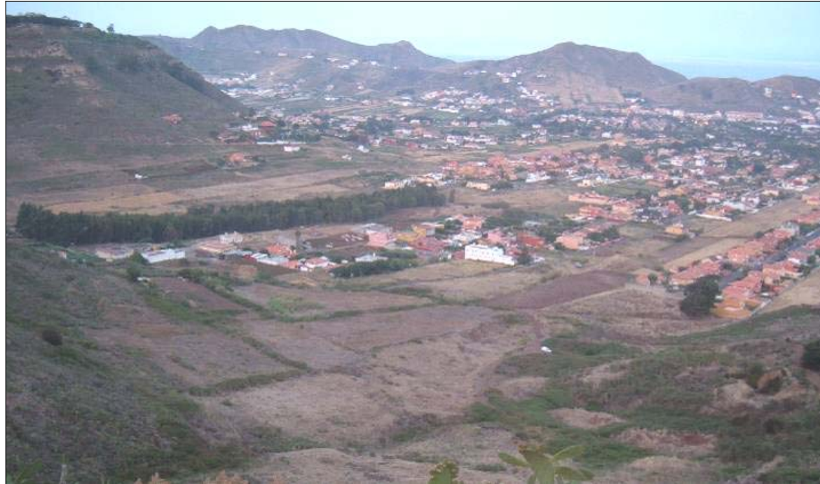
Proximidades de Montaña de la Atalaya y, al fondo vemos los terrenos por donde pasará la futura vía. Este tramo pasa por terrenos de erial y comunidades de malas hierbas con limitado valor naturalístico. El trazado coincide en su desarrollo con varias hileras de Eucaliptus globulus ( Eucaliptos ) y aglomeraciones de Rubus sp ( Zarzas ).
