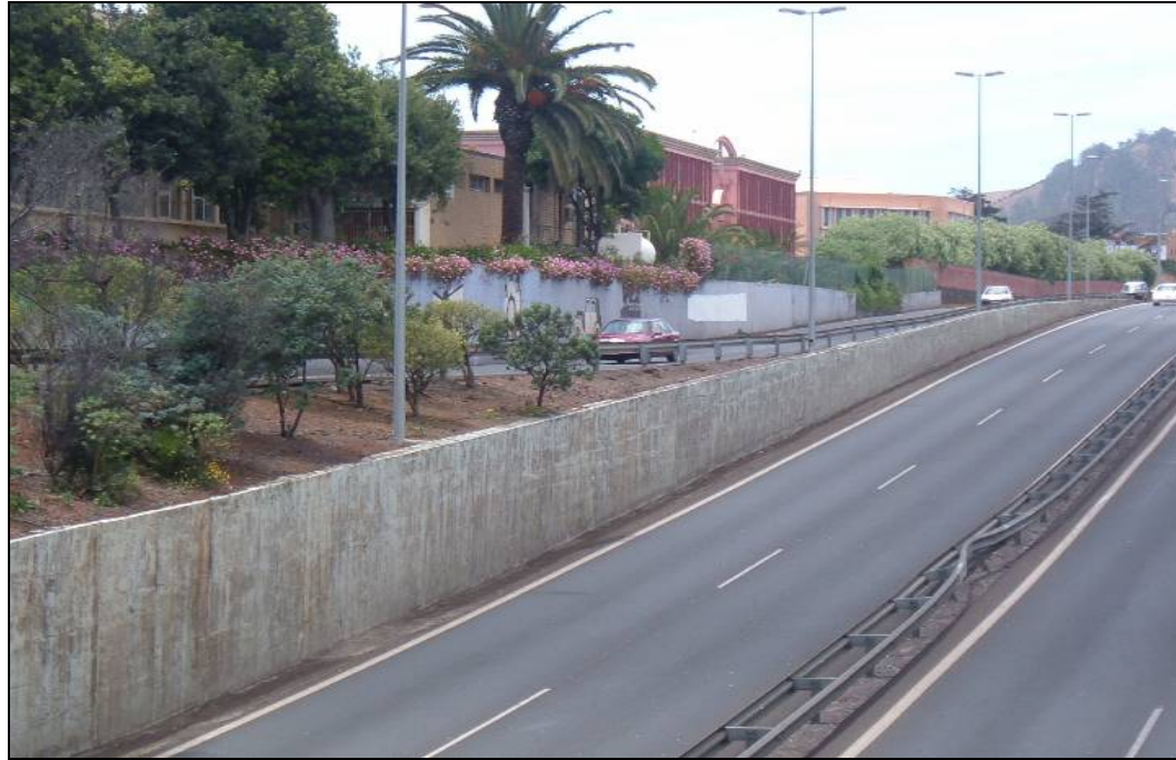
Foto 29-Taludes anexos en el margen izquierdo en la vista hacia el oeste de la actual vía. Al fondo observamos ejemplares de Phoenix canariensis (Palmera Canaria) que deberán ser reintegrados en la ordenación propuesta, así como las hileras de Schinus molle (Falso Pimentero).
