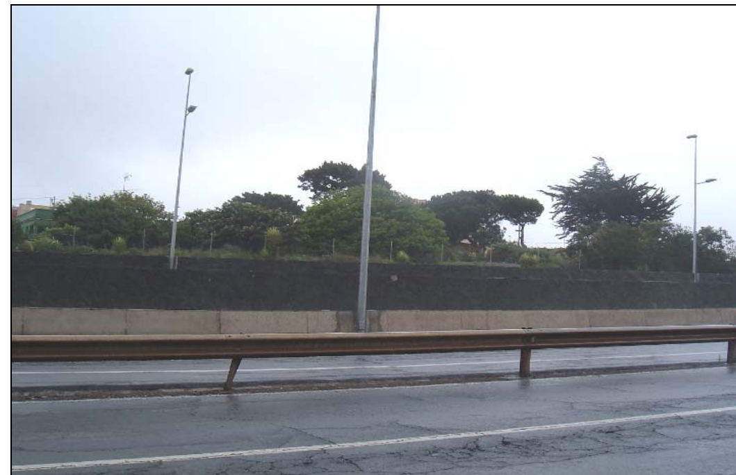
Foto 43- Detalle de la anterior fotografía. Los elementos vegetales se encuentran embelleciendo la traza. Existen igualmente algunos ejemplares de frutales, Castanea sativa (Castaños) y Cupressus sp.
