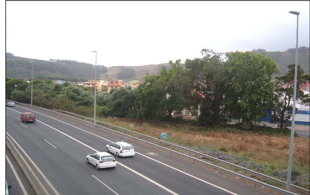
Foto 39- Terrenos de taludes a la altura del barrio de San Lázaro junto a la actual vía. Se observaron portes arbóreos de Platanus sp, Cupressus sp y Populus alba de indudable valor.
