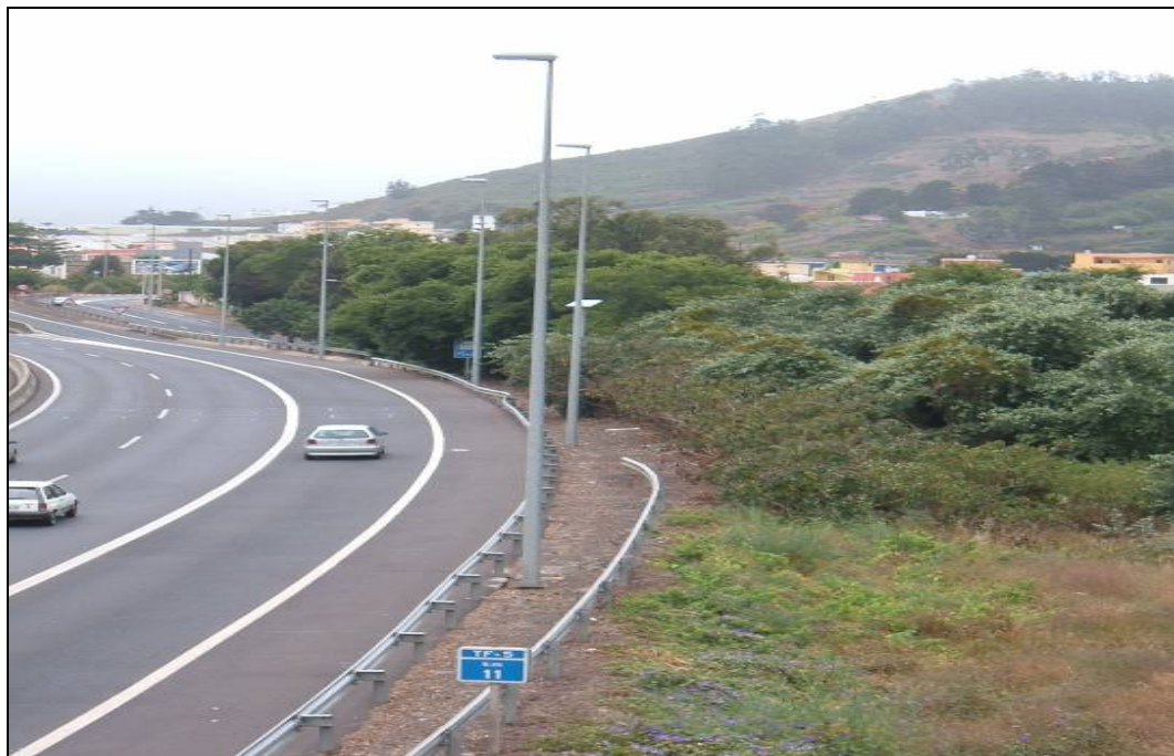
Foto 41- Detalle del punto de conexión de acceso al aeropuerto. Obsérvese la gran cantidad de pies de árboles junto al actual trazado de la carretera. Existe una gran aglomeración de Populus alba y un conjunto de erial cubierto con malas hierbas en el pie de la fotografía, sin ningún valor.
