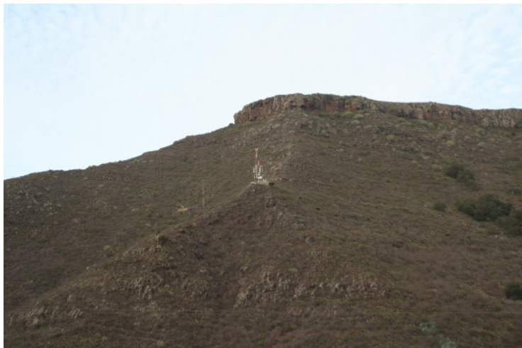
Foto N° 8: Vista de las infraestructuras de telecomunicación de Las Mesas, Tejina, desde la TF-13
