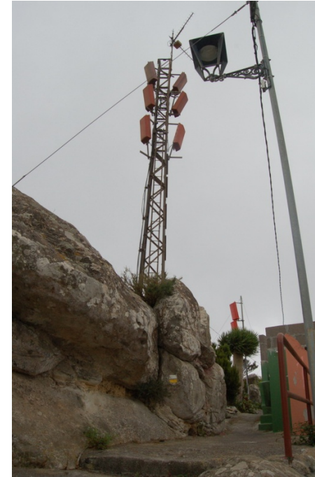
Foto N° 37: Ausencia de cerramiento en Las Cumbrillas
