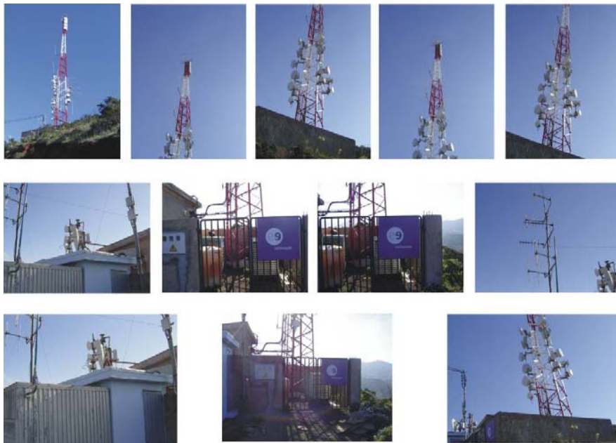
Instalación de radiodifusión situada en El Rosario
