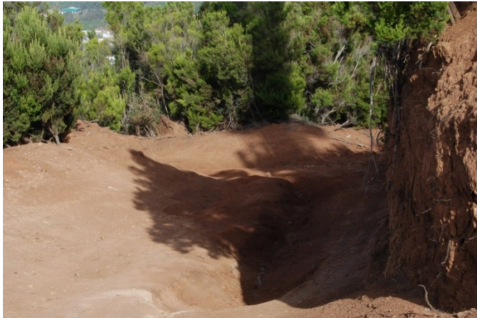
Foto N° 28: Pista acceso a infraestructuras en El Tanque en mal estado
