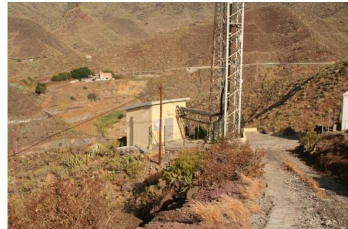
Foto N° 27: Pista de acceso a infraestructuras en El Suculum. Hormigonada
