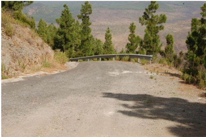
Foto N° 22: Acceso asfaltado a infraestructuras en Montaña de Gala
