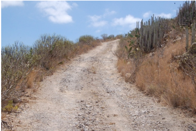
Foto N° 20: Pista de acceso a infraestructuras en Roque de Jama
