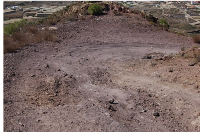
Foto N° 21: Pista de acceso a infraestructuras en Montaña Gorda
