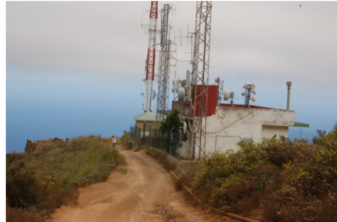
Foto N° 29: Pista de acceso a infraestructuras en Anочеza
