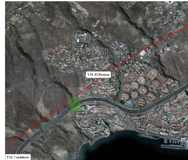
Ilustración 7.3 -Área con posible afección. Municipio de El Rosario.
