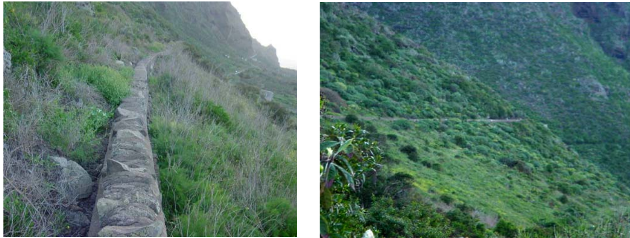
Canal de la red principal a su paso por el municipio de Buenavista del Norte Red principal de canales. Acueducto IcodBuenavista del Norte.
