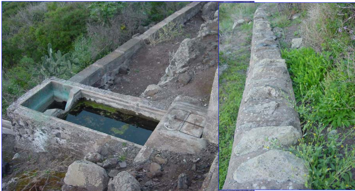
Conexión entre red principal y secundaria de riego.
